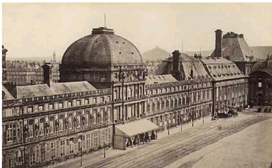
Tuileriespaleis voor 1871. Paleis van Napoleon III. (In 1871 door brand verwoest.)
